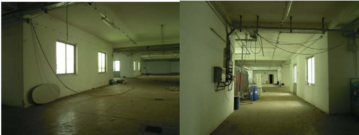
Fig. 5 vista di cavi tagliati in altri vani dell'opificio.
